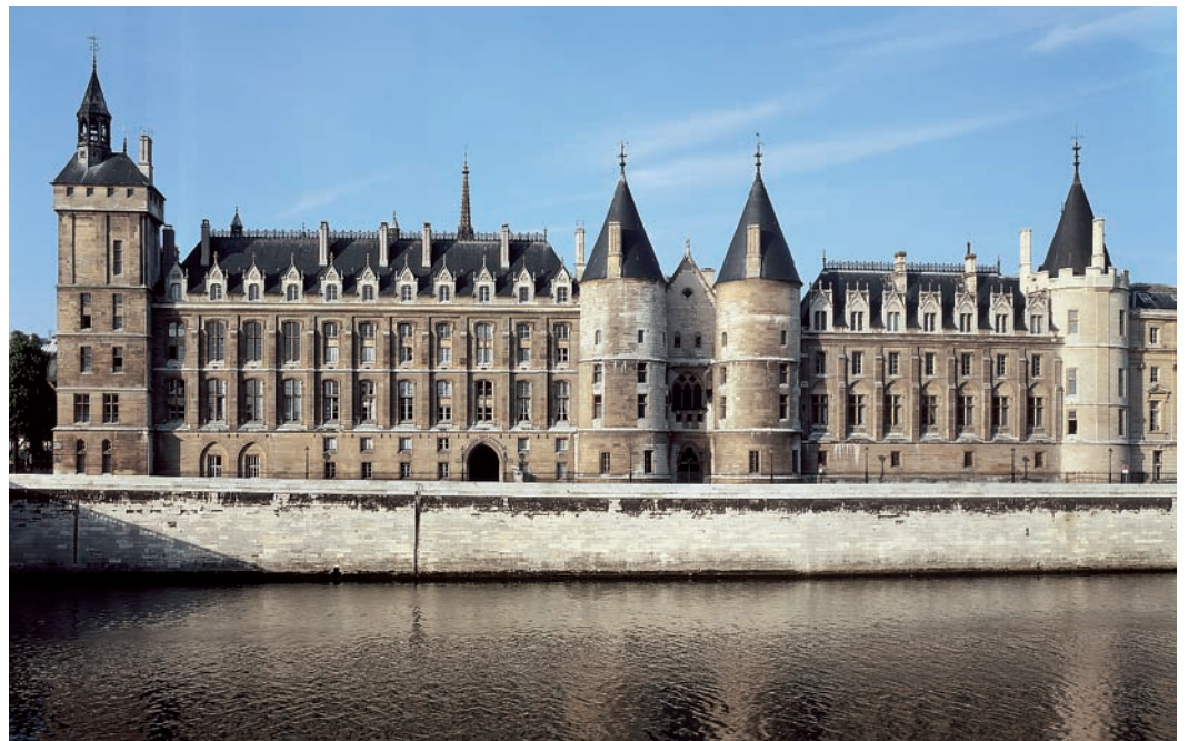
Conciergerie façade nord, de gauche à droite : Tours de l'Horloge, César, Argent et Bonbec.
