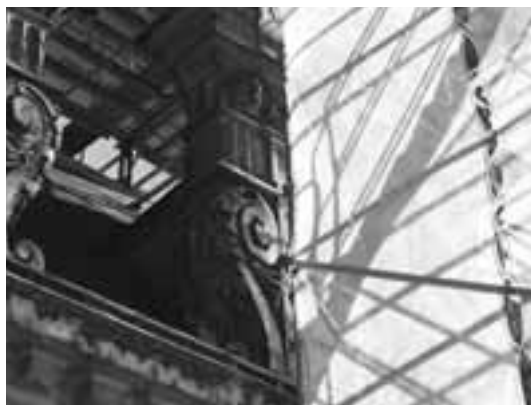
Travaux à l'Hôtel de Sully
