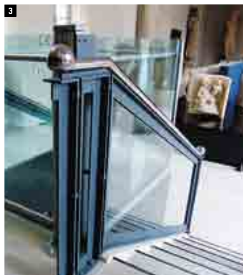
1 Début des travaux à l'Hôtel de Sully
