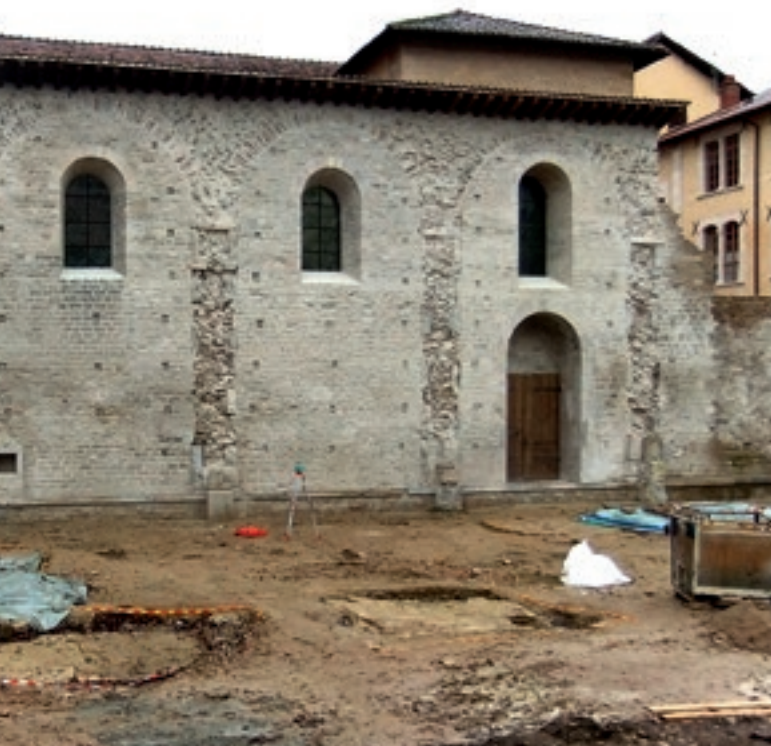
Abbaye de Cluny, restauration du mur de la nef
