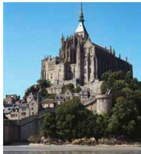
> L'abbaye du Mont-Saint-Michel, de multiples chantiers
